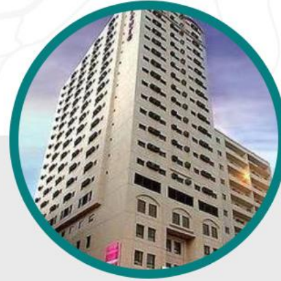
اعمال الكهروميكانيكا لفندق هبة الله مكة مشروع مسجد الليث
